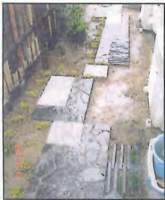
鉄平石乱貼りの延段 短冊石と瓦がポイント
