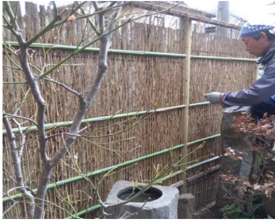
施工中の“A”邸 時雨垣
